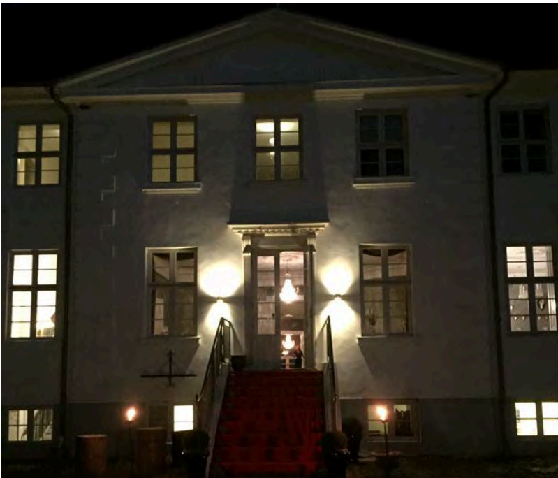
Eksisterende belysning af hovedbygningen på Jomfruens Egede.
