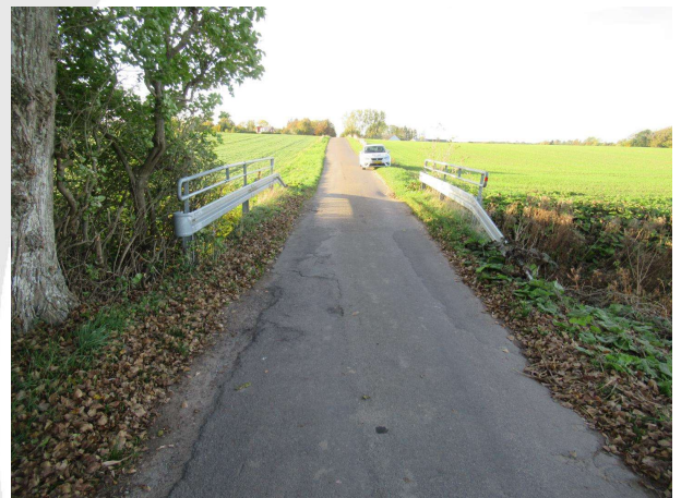
2. Overført vej set mod øst
